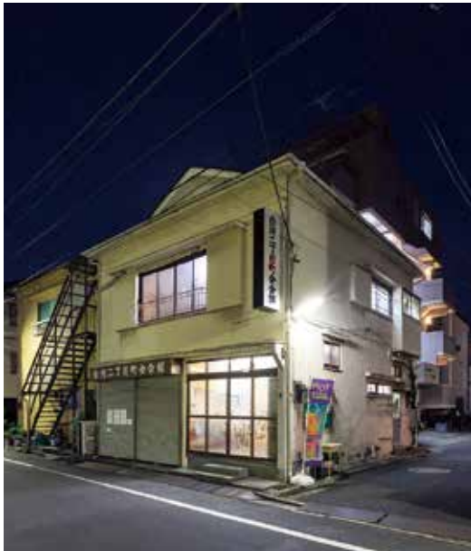
MOTスペースG 白河二丁目町会会館、鈴木のぞみ「The Light of Other Days : 白河二丁目町会会館」
