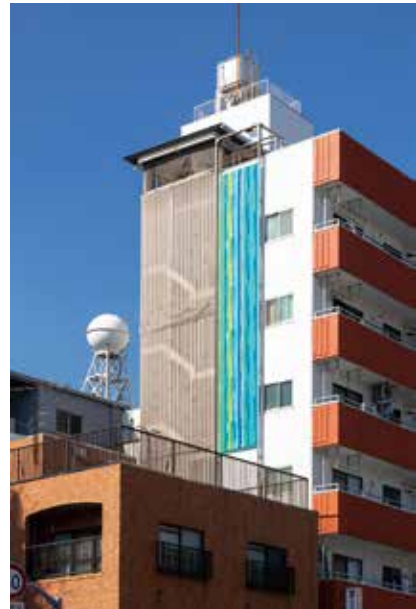
MOTスポットa ささきビル (外壁)、ひがしちか
