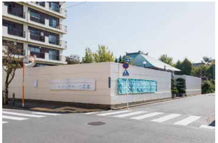
MOTスポットf 善徳寺(外壁)、ひがしちか
