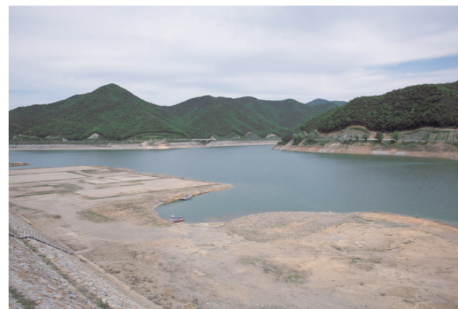
華北里、鶴城里、仁谷里、槐山里が沈んでいるダム 慶尚北道軍威郡古老面 2013年 Under the water, there are Hwabuk-ri, Hakseong-ri, Ingok-ri, and Goesan-ri in Goro-myeon, Gunwi-gun, Gyeongsangbuk-do, 2013
