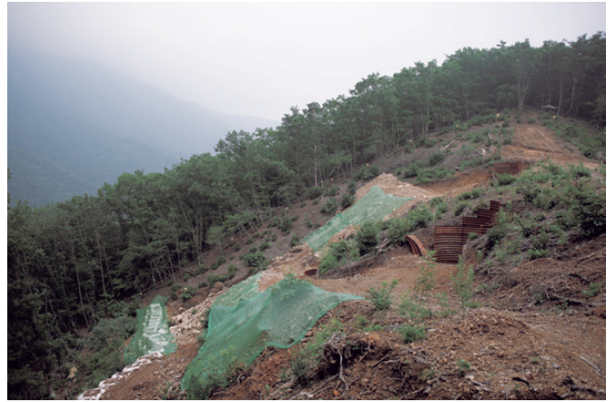
送電塔の建設予定地、 慶尚南道古禮里密陽 2013年 Designated area for a transmission tower, Gorye-ri, Miryang, Gyeongsangnam-do, 2013
